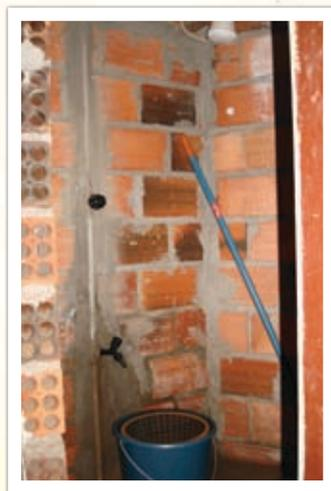
Box do chuveiro construído de forma improvisada e sem revestimento
