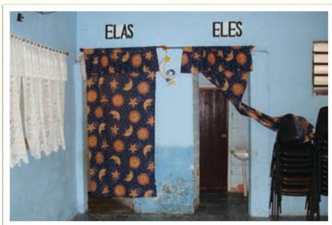
Pintura deteriorada ocasionada por infiltração na entrada dos banheiros
