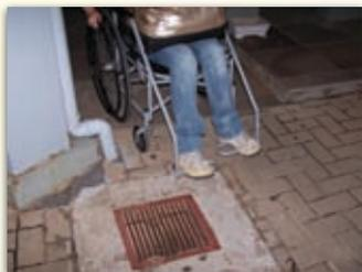
**CIRCULAÇÕES** – Participante do exercício com dificuldade de circulação pelo campus, deparando-se com pisos irregulares após rampa inadequada - diferentes pavimentações e desníveis.
